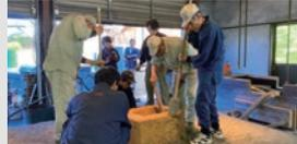
土を練り、炉を築きます。築炉後、薪を燃やし炉を乾燥させます。
